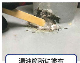
漏油箇所に塗布
